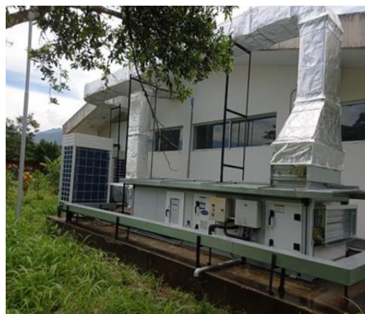
Imagen 24: Construcción e instalación del sistema de aires acondicionados y ventilación mecánica de los laboratorios de investigación de la Universidad Regional Amazónica Ikiam
