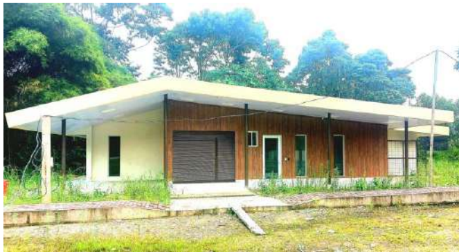
Imagen 15. Avance en la construcción de laboratorios de investigación
