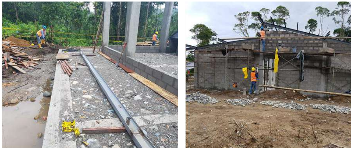
Imagen 7. Avance en la Construcción y mobiliario de laboratorios de investigación
